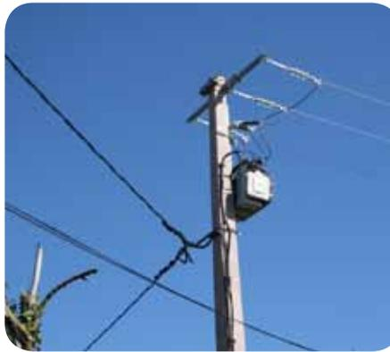
La desserte électrique a par ailleurs été fiabilisée, en remplaçant des portées en fils nus par du câble torsadé, au niveau des postes « 9 Bergerette », « 5 Boulet » et « 29 Garac ».
